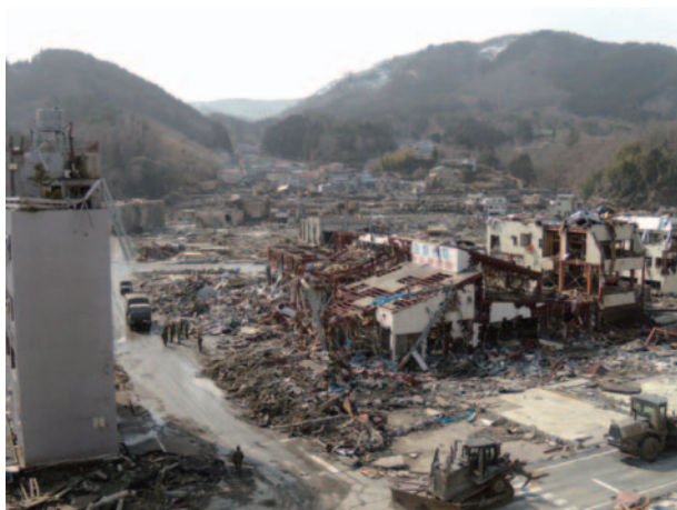
図2 女川で最も大きいスーパーだった「おんまえや」も壊滅的な被害を受け、その横の3階建てビルの屋上にはひっくり返った車が乗っている。
